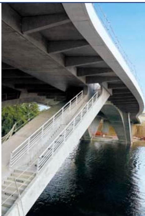
*Escaliers en béton préfabriqué en encorbellement placés dans l'axe des piles permettant se séparer les piétons des voies routières.*
